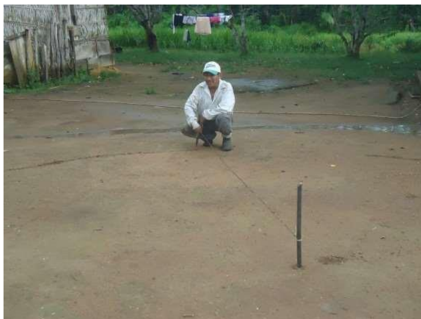
Figura 3.5: Desenho de circunferência no chão para construção de maloca tradicional.
