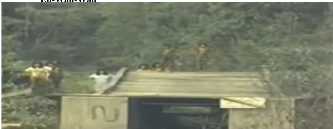
Figura 8 - Abertura de estradas secundárias dando acesso à reserva indígena Uru-Eu-Wau-Wau
