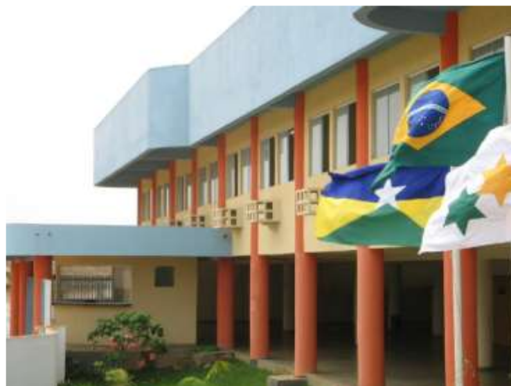
Figura 4 - Fachada de entrada da escola Jovem Gonçalves Vilela.
