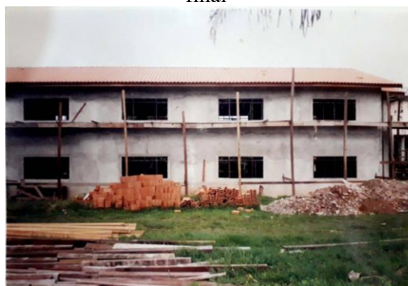
Figura 7: Construção dos dormitórios fase final
