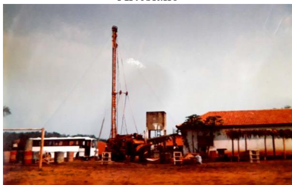
Figura 4: Construção do Poço Artesiano
