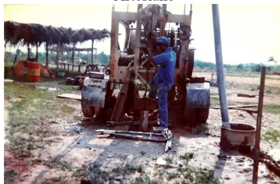
Figura 5: Construção do Poço Artesiano
