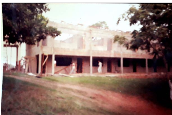
Figura 6: Construção dos dormitórios
